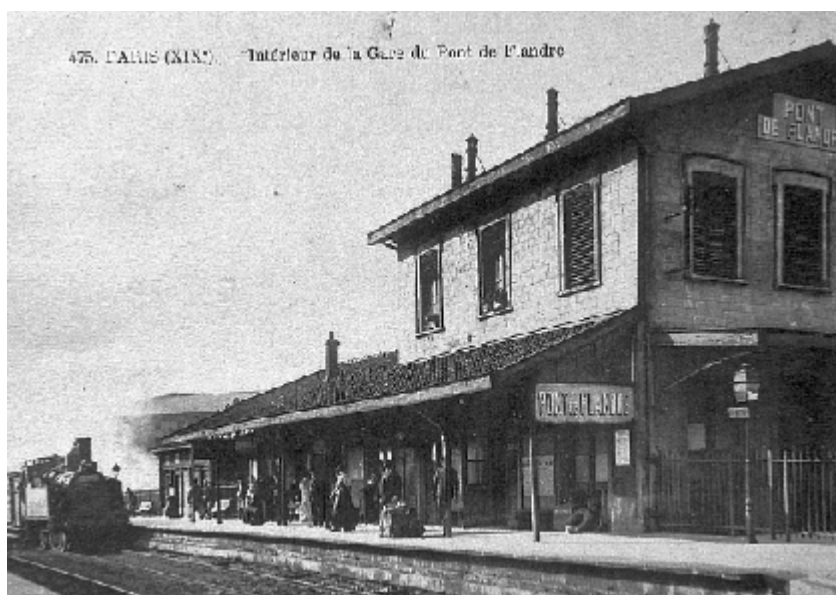
Pont de Flandre
